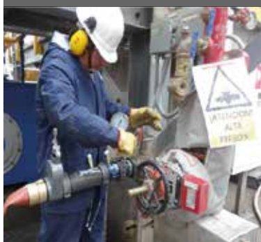
MANGUERA CONTRA INCENDIO
