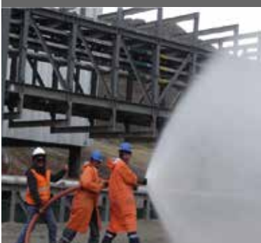
MANGUERA CONTRA INCENDIO
